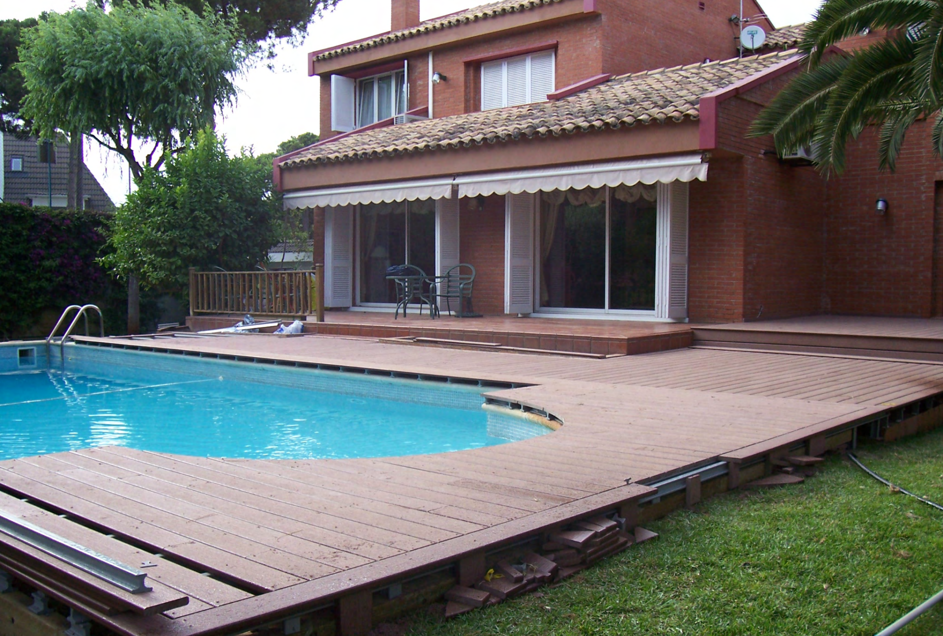
Instalación Platja d'Aro (Costa Brava)
